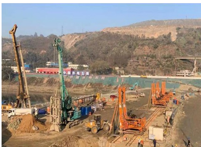
银江水电站旋挖+液压抓斗防渗墙成槽施工
