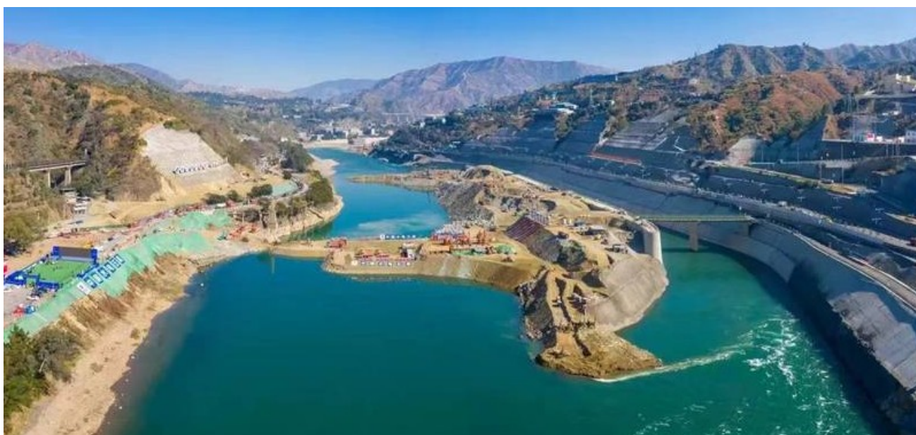
银江水电站施工全景
