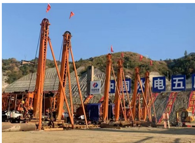
银江水电站乌卡斯防渗墙成槽施工
