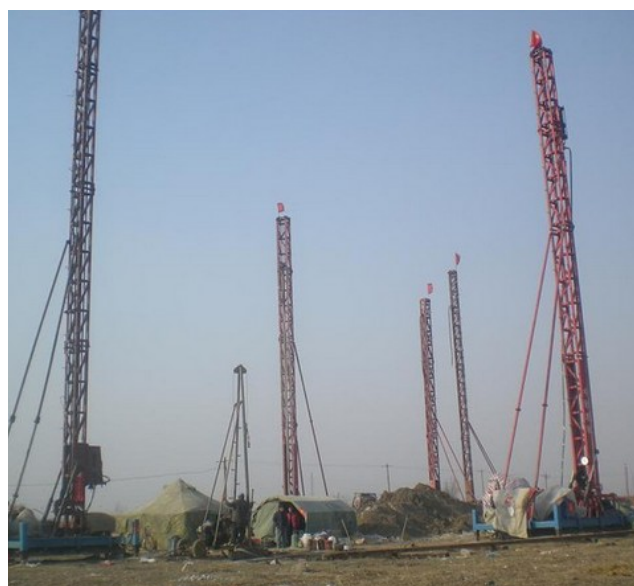
佛山环岛北路市政道路水泥搅拌桩工程
